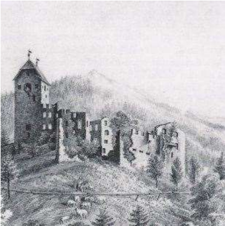
Alte Ansicht der Jauffenburg.
